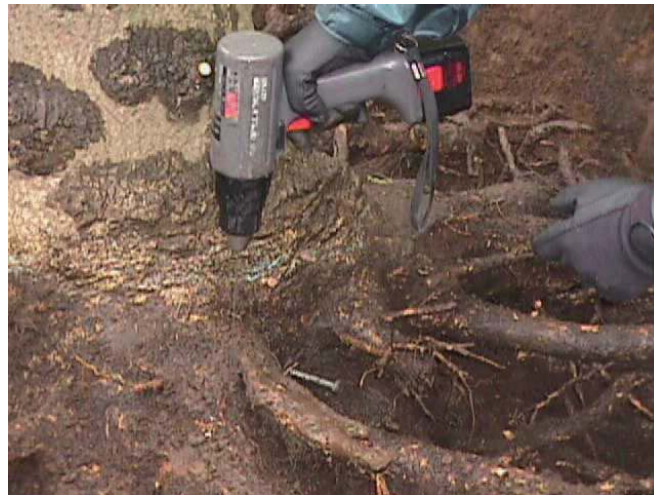
写真-IV.3 ドリル等による根系腐朽状況の確認
