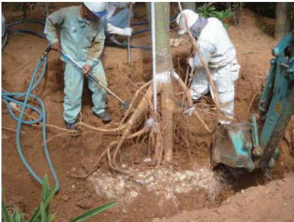
写真-2.5 全面掘削方法
