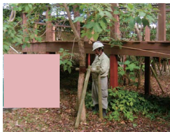
写真-Ⅲ.7 支柱の結束直し
