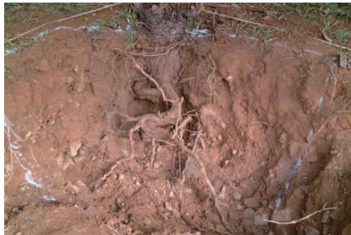
写真-2.15 植栽基盤の整備不良による根系伸長不良（モンパノキ）
