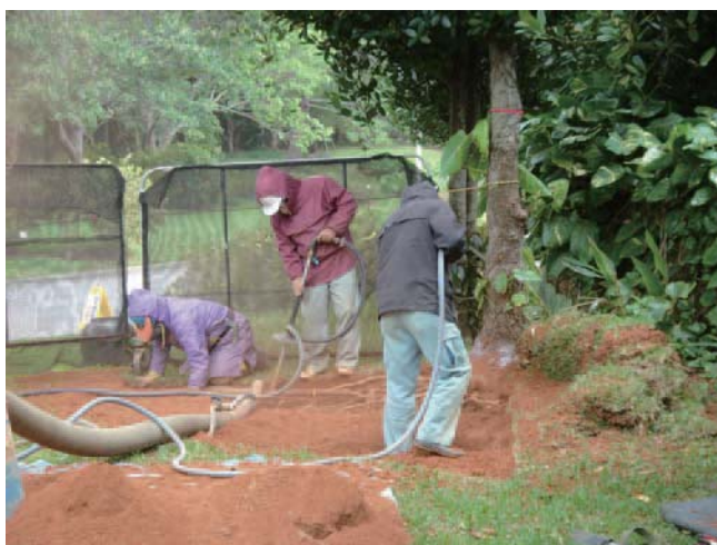
写真-2.2 水平方向の土壌掘削
