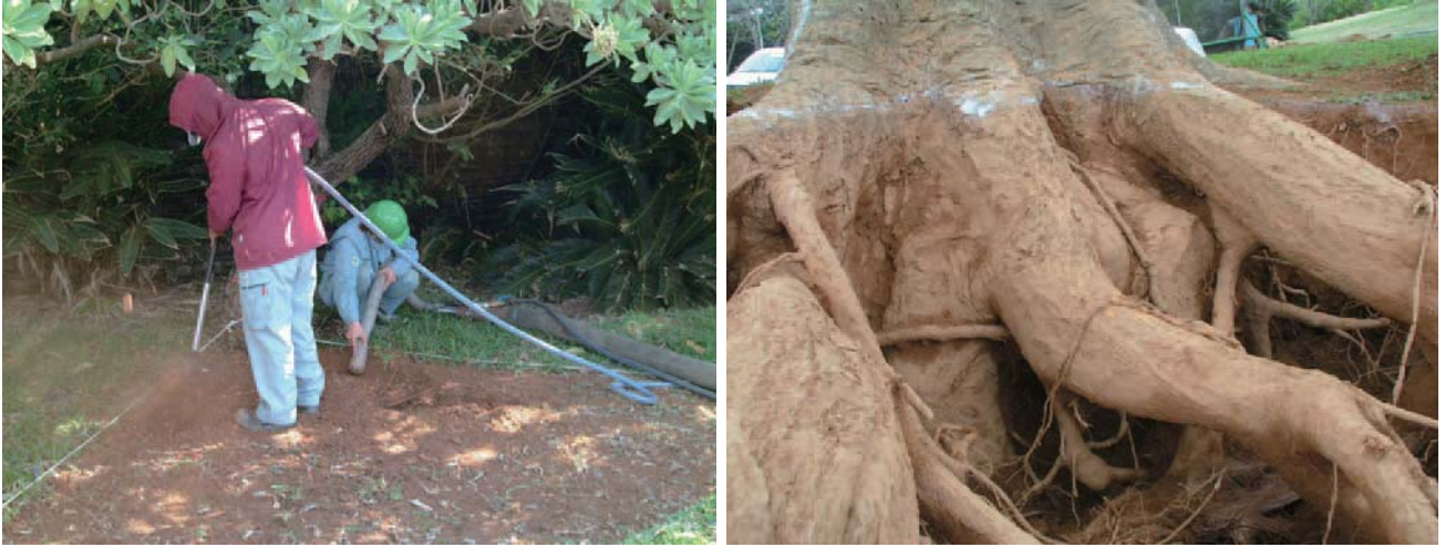
写真-IV.2 圧縮空気による土壌掘削
