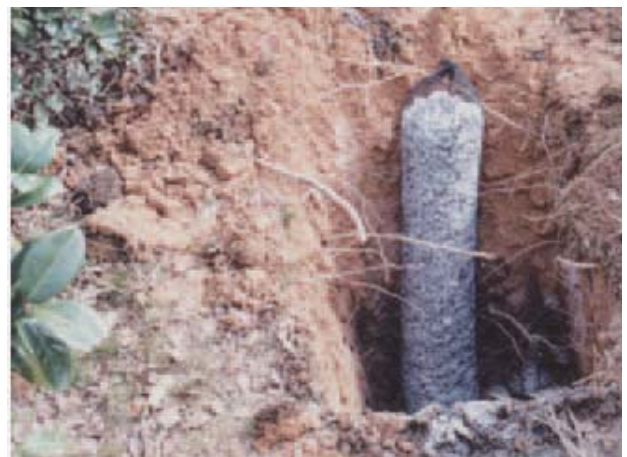
写真-IV.19 排水工の例
