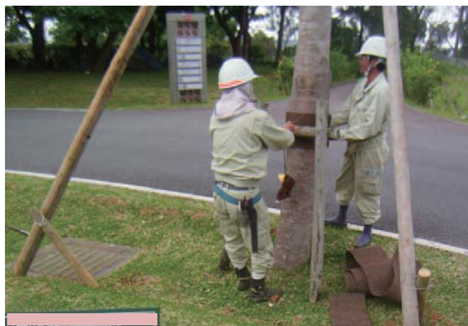
写真-IV.15 支柱の補修
