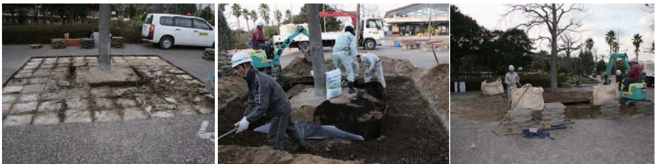
（植栽基盤の拡張作業）
