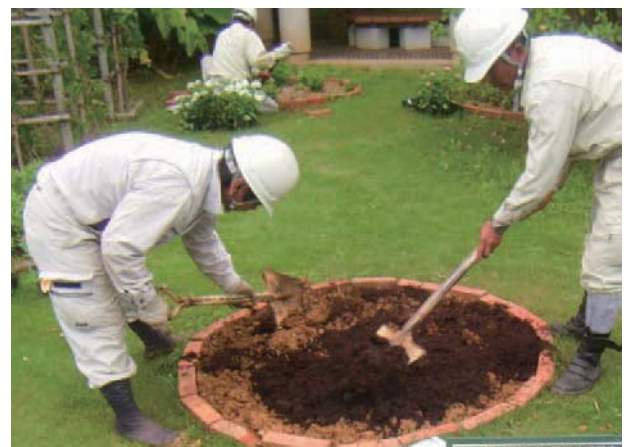
写真 - II .10 土壌改良材の混入
