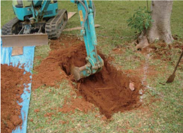
写真-2.4 小型バックホウによるトレンチ掘削
